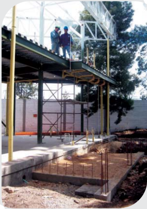
Estructura metálica Entrepiso en metaldeck Cañuelas con recubrimiento para bajantes de aguas lluvias y sanitarias
