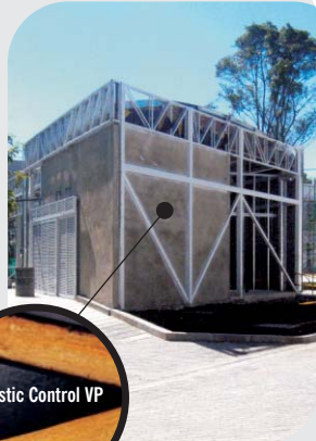
Aislamiento interno termoacústico para muros de fachada en fibrocemento
