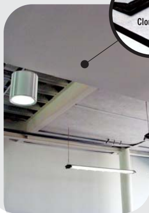
Cielo raso acústico en el área de oficinas
