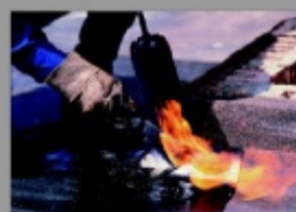
Instalación de mantos
